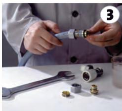
**3** Enfoncer le tube bien à fond dans la tétine du raccord et positionner le joint O-Ring à fond de gorge.
