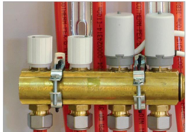
Les volants manuels R450H sont montés sur les robinets d'arrêt micrométriques des collecteurs R553D et R553F. Ils permettent l'ouverture et la fermeture manuelle des différents circuits.
