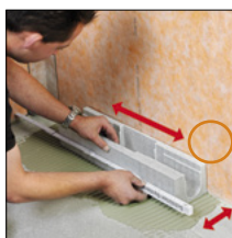
=> 1. Ajuster le support de caniveau
