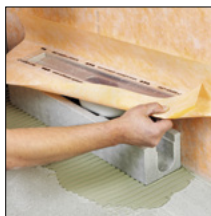
=> 2. Mettre en place le corps de caniveau
