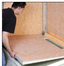
=> 3. Pousser le receveur en pente sous le bord du corps de caniveau
